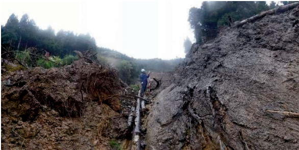
写真-7 堆積域の左側部 (2017. 10. 29 撮影) (高さ 6~8m 上部まで通過した痕跡が残る)
