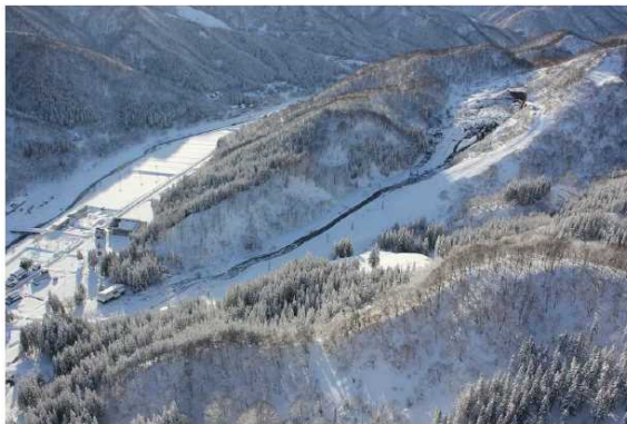
写真-1 南砺市上百瀬で発生した土砂災害（地すべり）の全景写真（平成29年1月17日富山県撮影）
