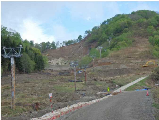
写真-8 災害復旧工事状況の例
