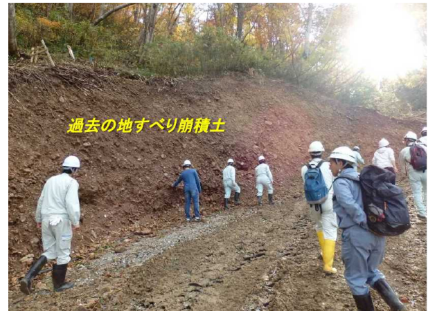
写真-7 発生域東側斜面における切土 (平成 29 年 11 月 2 日撮影)
