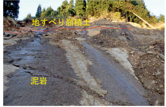
写真-8 泥岩面とその上面の湧水 (下面:泥岩勾配 40度, 上面:崩積土)
