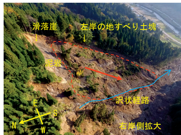
写真-4 地すべり土塊と移送域の沢経路（2017.11.5撮影）
