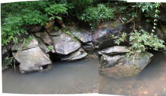
写真 3 笹川に面した斜面で確認した開口亀裂の状況
