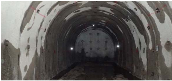
写真 1 大石西山排水トンネル終点部の施工状況
