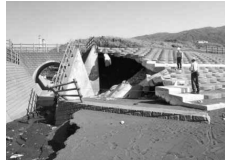
海岸施設調査状況(元町金づば地先)
