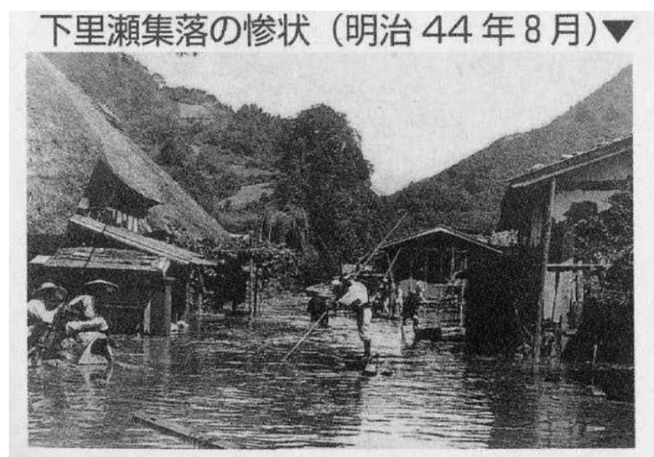
写真-1 1911年稗田山崩壊で姫川が堰き止められて出現した長瀬湖（国交省北陸地整松本砂防事務所）
