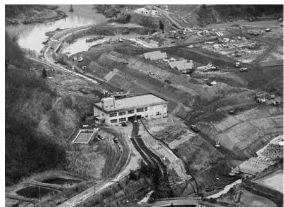
写真－4 東竹沢地区施工状況(2004)
