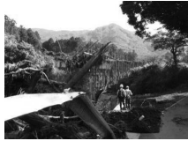
砂防施設調査状況 (八重沢P4砂防堰堤)
