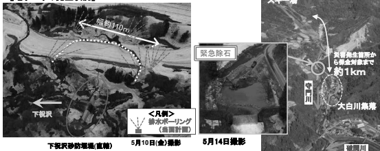
下沢沢砂防堰堤(直轄) 5月10日(金)撮影
