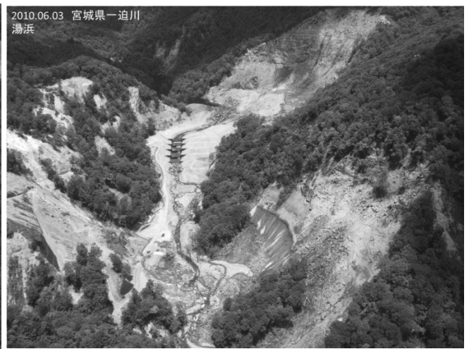
写真－9 流路工の施工状況(2010)
