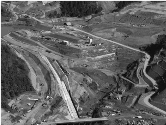
写真-5 東竹沢地区施工状況(2005)
