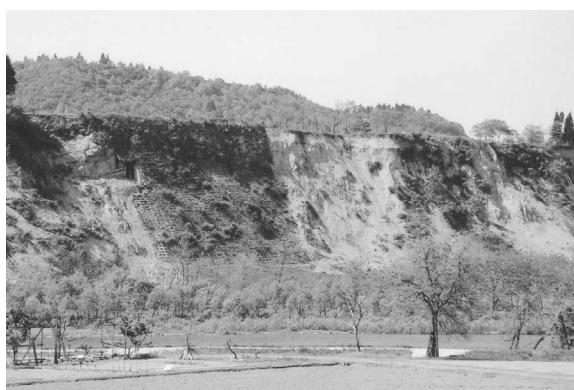
写真-4 小千谷市塩殿の段丘崖の肩で発生した崩壊
