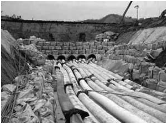
写真－3 ポンプ排水状況
