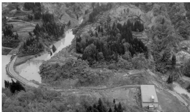
写真-4 東竹沢地すべり正面写真
