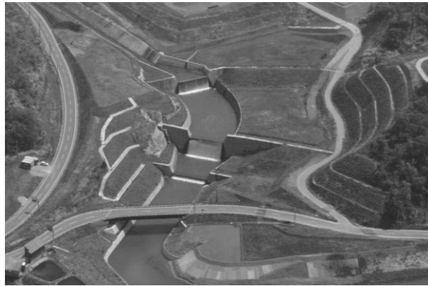
写真-6 東竹沢地区工事完了状況
