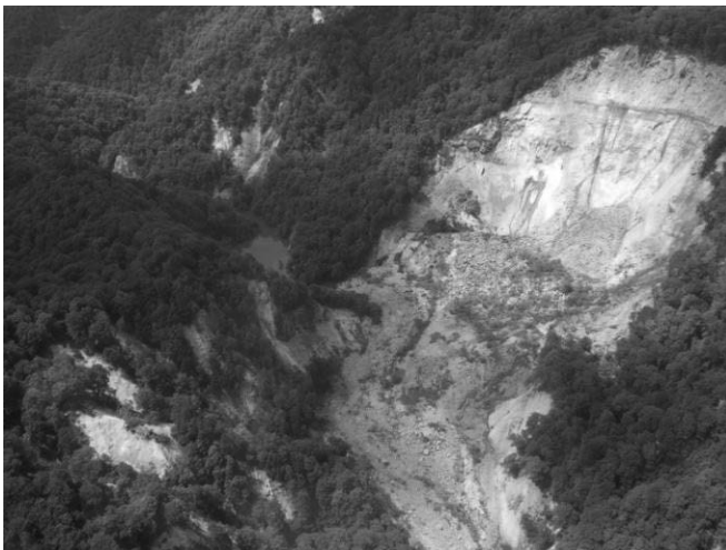
写真－8 湯浜地区天然ダム形成直後(2008)
