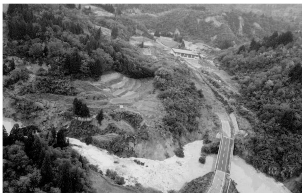
写真-1 東竹沢地すべりによる河道閉塞
