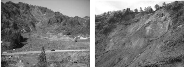
図-12 調査箇所全景・崩壊部
