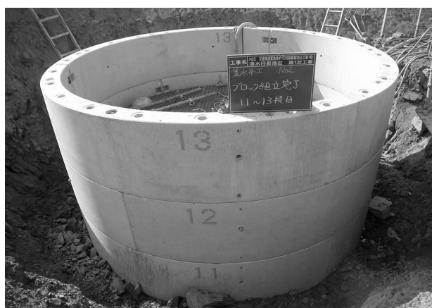
図-6 コンクリート製集水井施工状況
