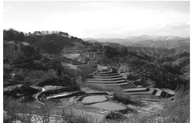
図-10 復旧後の清水棚田（H24. 12. 6撮影）
