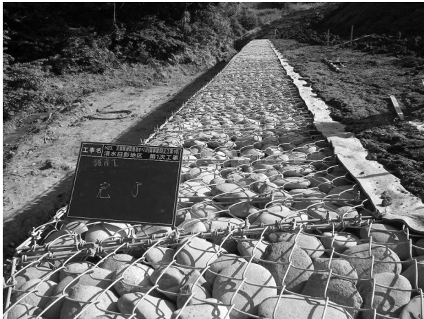
図-8 鋼製ふとん籠設置状況
