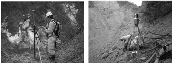
図-13 計測点設置 (GNSS)・計測状況
