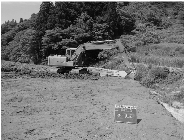
図-9 鋼製ふとん籠土砂の覆土による遮蔽
