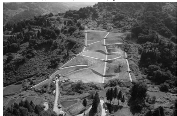
写真 1 主な地すべり対策工 (妙高市花立地区)
