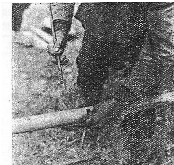
写真-2 保孔管は節をくりぬいた竹を使用した
