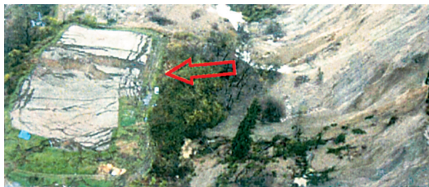
写真-3 水田の亀裂発生状況。
