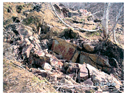
写真-5 鞍部付近に見える開口亀裂 (写真-4の四角範囲)。
