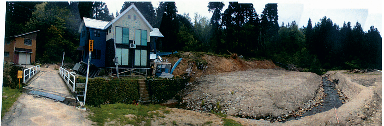
写真 5, 釜沢川仮復旧状況
