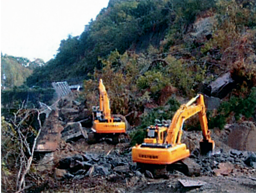
写真-1 中越地震災害現場での復旧作業（長岡市妙見）
