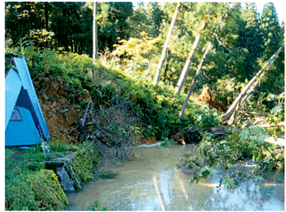
写真 4, 釜沢川の閉塞状況
