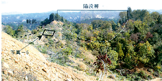
写真-4 頭部付近の陥没帯。
