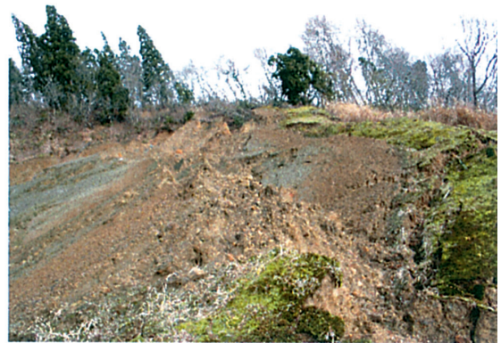
写真-3 後部へ傾斜する斜面における階段状変形 (写真-2の四角範囲)
