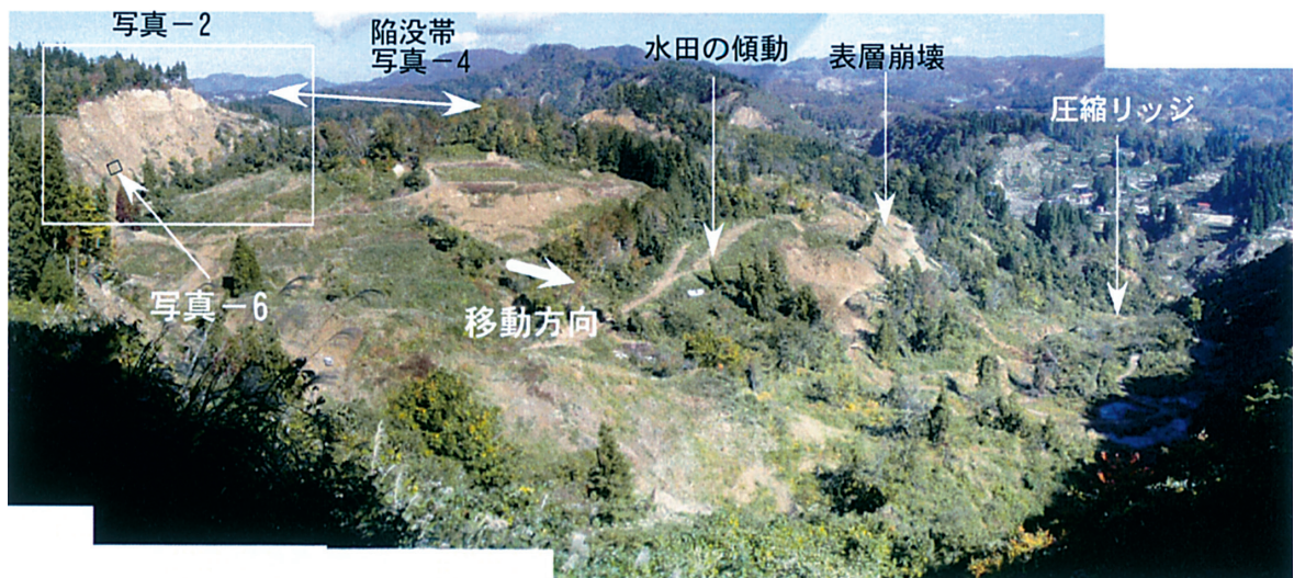
写真-1 塩谷神沢川地すべり全景（北東方向を望む 2005年11月撮影）
