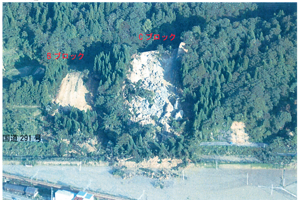
写真-5 B・Cブロック全景
