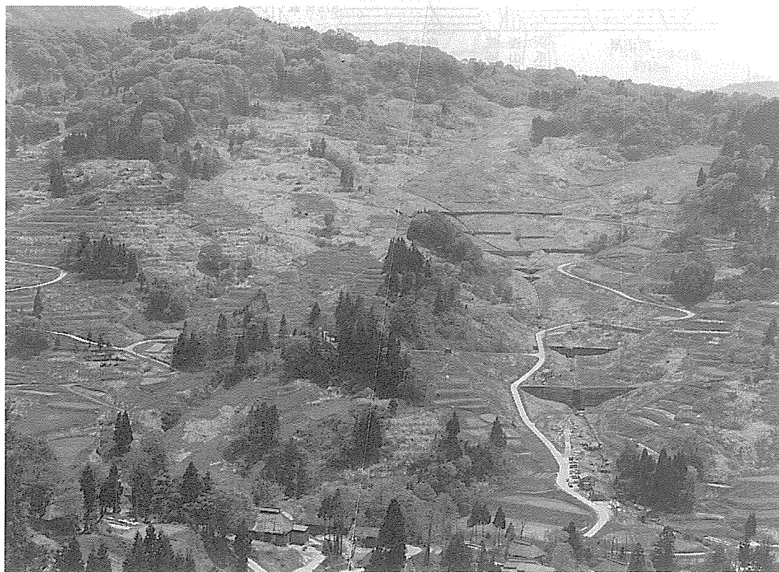
写真-1 八幡地すべり防止区域蛇香沢地区を対岸から望む
