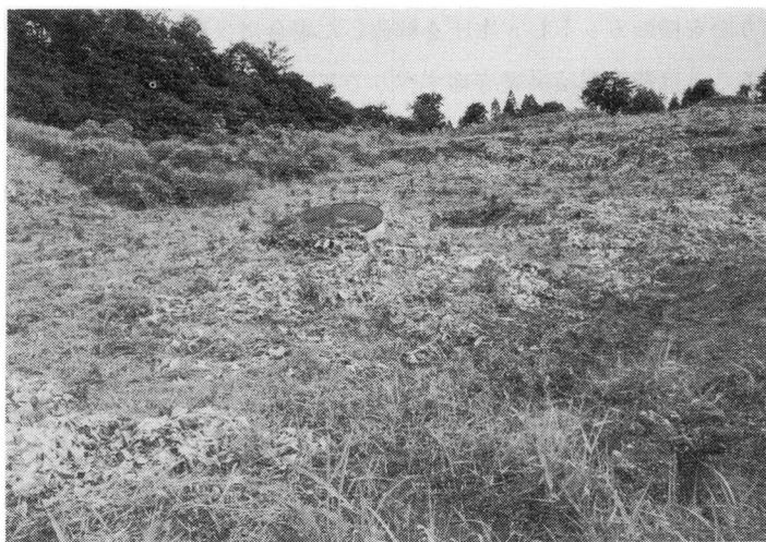
写真1 集水ボーリングを行った結果陥没を起した神谷地すべり
