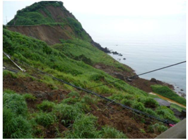
写真-2 柏崎市米山地区。聖ヶ鼻の北東側の斜面で発生した地すべり。聖ヶ鼻方向を臨む
