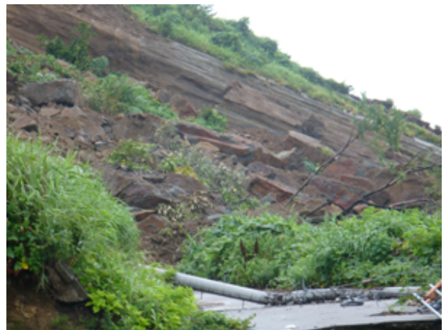
写真-6 柏崎市米山地区。聖ヶ鼻の北東側の斜面で発生した地すべり。地層の傾斜方向に沿って滑落した層すべりである
