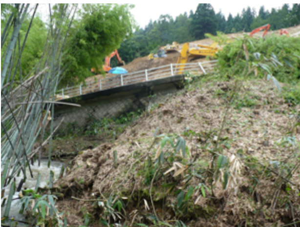
写真-11 長岡市大積千本町地区。地すべりによって押し出された土塊。中段には破壊された道路の残骸がある。
