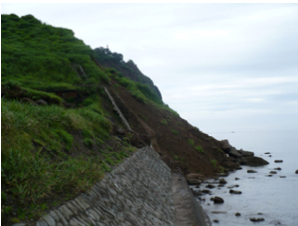
写真-5 柏崎市米山地区。聖ヶ鼻の北東側の斜面で発生した地すべり。末端部の様子
