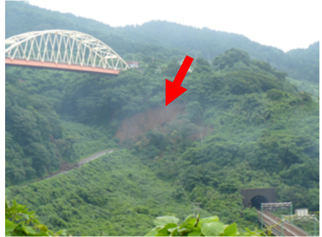
写真-8 柏崎市上輪地区。斜面崩壊による土砂が道路上に堆積している。
