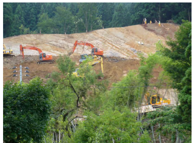
写真-12 長岡市大積千本町地区。切り土によって現れた地層。地層の傾斜（写真左上から右下へ傾斜）と地すべりの移動方向（写真奥から手前）は斜行している。
