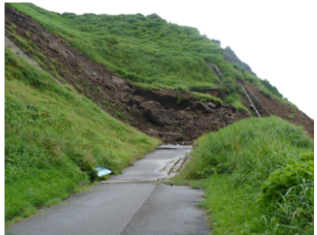
写真-4 柏崎市米山地区。聖ヶ鼻の北東側の斜面で発生した地すべり。末端部の様子
