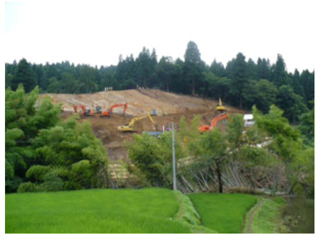
写真-10 長岡市大積千本町地区。地すべりによって国道8号線が破壊された。斜面の切り土、土砂の撤去、道路の仮設工事が進められていた
