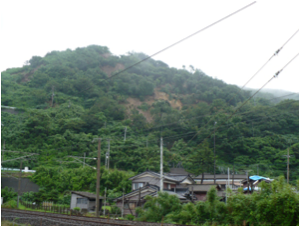
写真-1 柏崎市米山地区。聖ヶ鼻へ伸びる稜線の西側斜面（米山集落側）で発生した斜面崩壊
