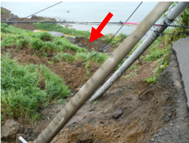
写真-3 柏崎市米山地区。聖ヶ鼻の北東側の斜面で発生した地すべり。撮影者の立つ道路が矢印の位置まで滑落した
