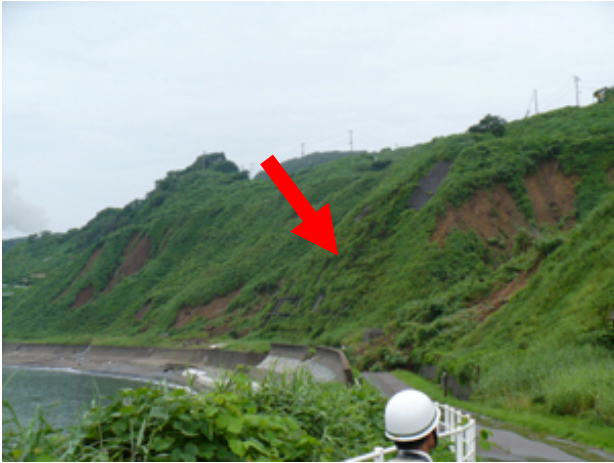
写真-7 柏崎市上輪地区。海岸に沿う急崖の斜面崩壊。のり枠工の張る場所は崩壊していない。
