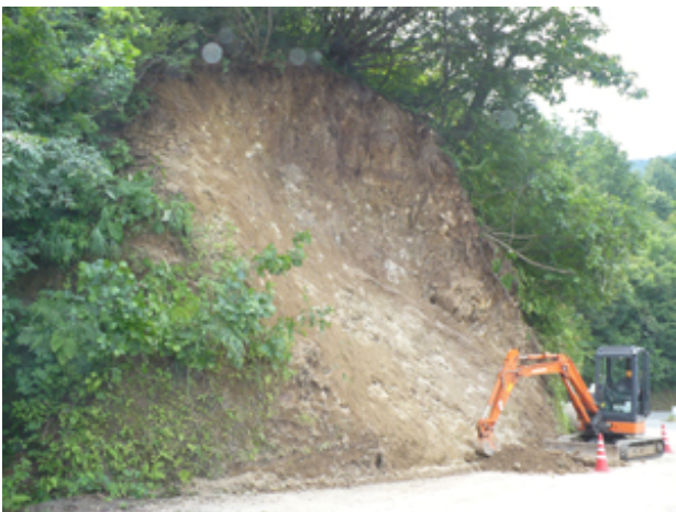
写真-5 柏崎市小村峠地区。写真-4の下方にある切り土のり面の崩壊
