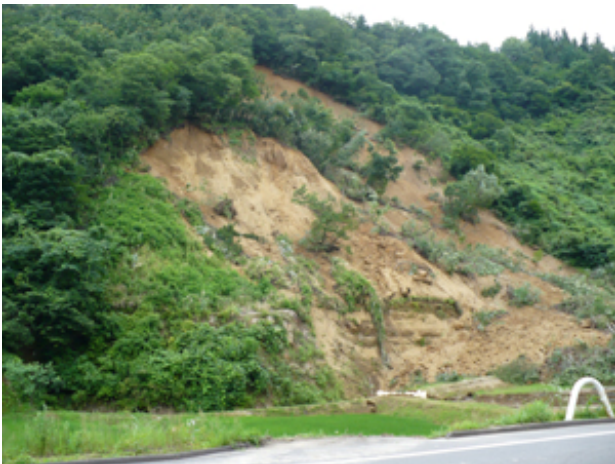
写真-11 長岡市小国町芝ノ又地区。斜面崩壊の様子
