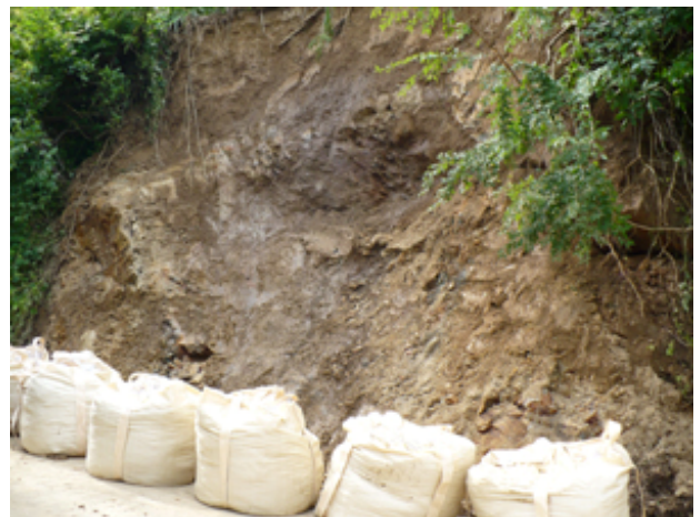
写真-6 柏崎市阿相島地区。深水橋南方、切り土のり面の崩壊
