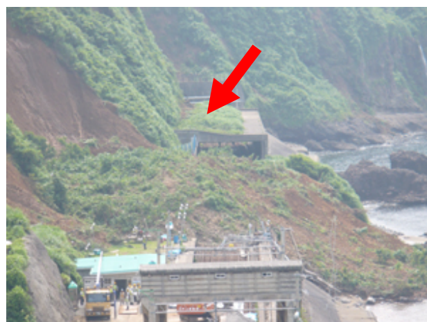
写真-2 柏崎市青海川地区。崩壊の奥、ロックシェット上の古い堆積物とそれを覆う植生
