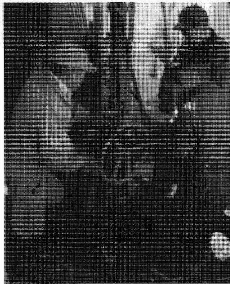
写真2.6.37 建て込み孔のボーリング (福本安正氏撮影)
