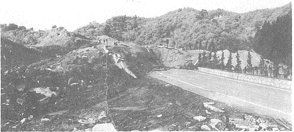
写真一 1 地すべり末端部の隆起地形。県道が3～5m程度隆起し、舗装面が波うっている。
