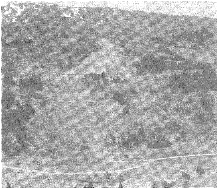
写真一 2 四十刈地すべり地全景…上部は斜面整地が進み、安定化しつつある。下部は県農地部による杭打工、水抜ボーリング工及び圃場整備中。
