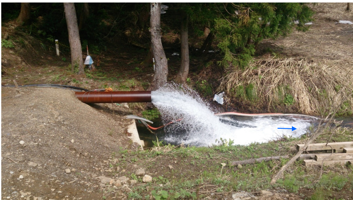
写真 7-1 地すべり状況写真⑤の位置に排出される中部拡大ブロック集水井群の排水 ST 工法によるφ300mmの排水状況 2014 (H26) /5/1 : W2 号井内湛水 1.67m 発生中のもの
