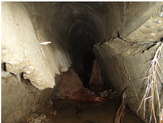
中部ブロック頭部排水トンネル内部変状：2012（H24）/7/25 左：坑口から約7mの変状 側壁覆工コンクリートが座屈している 右：約16m付近 約4m先で礫の押し出しにより進入不可
