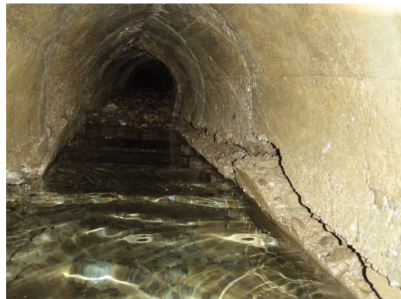
中部ブロック頭部排水トンネル内部変状：2012（H24）/7/25 左：坑口から約7mの変状 側壁覆工コンクリートが座屈している 右：約16m付近 約4m先で礫の押し出しにより進入不可
