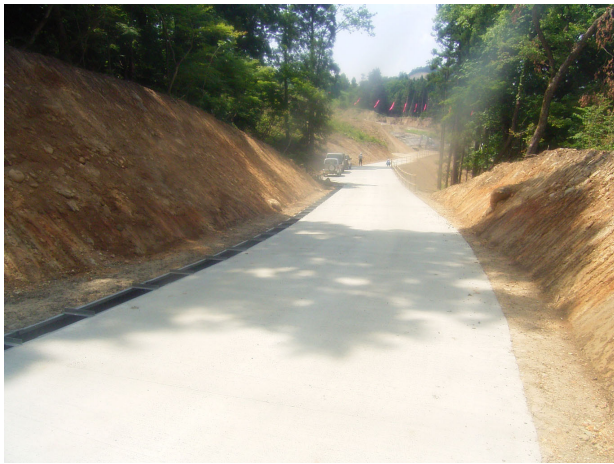
写真 13 地すべりブロック北東部 猿橋層の露頭
