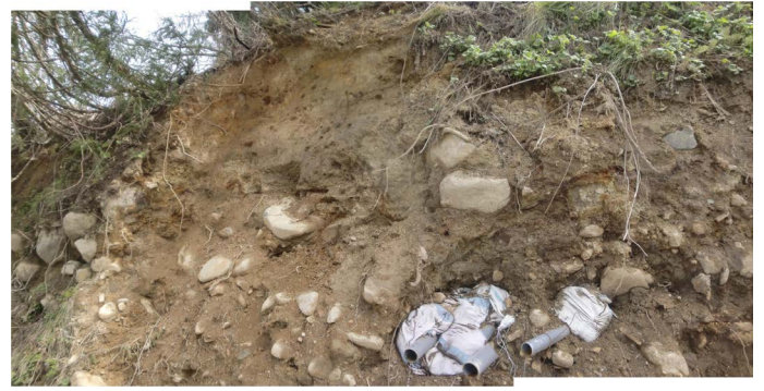
写真 12 工事用道路脇にみられる砂礫(猿橋層 Sg)
