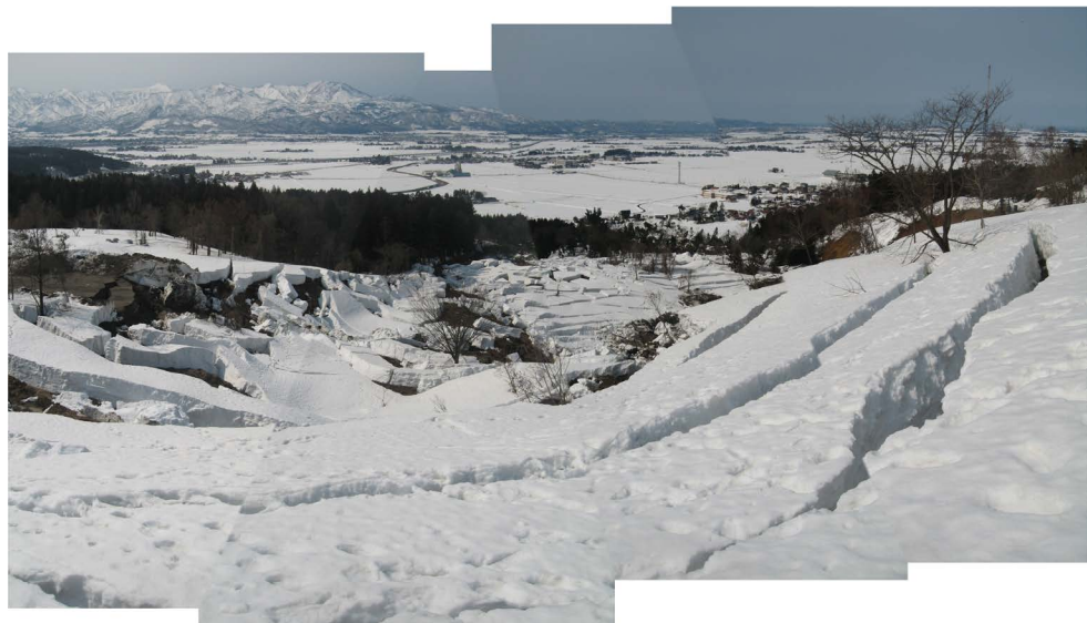
写真4 滑落崖右上部斜面も、雪面に亀裂が入り崩壊が拡大傾向にある。
