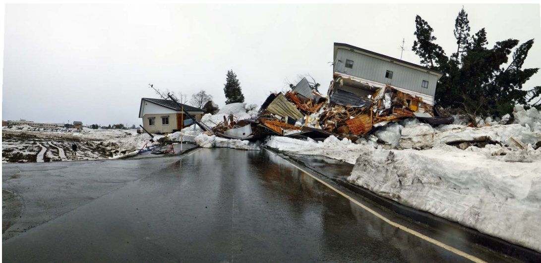
写真 20 県道上の状況 3/17 撮影。
