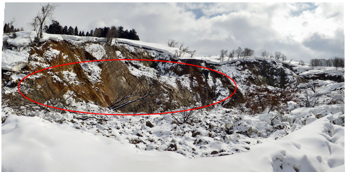
写真 2 崩壊が拡大することにより、崖中央部～左側部下部で須川層泥岩の露岩がみられる。右側部は、崩積土が分布する。
