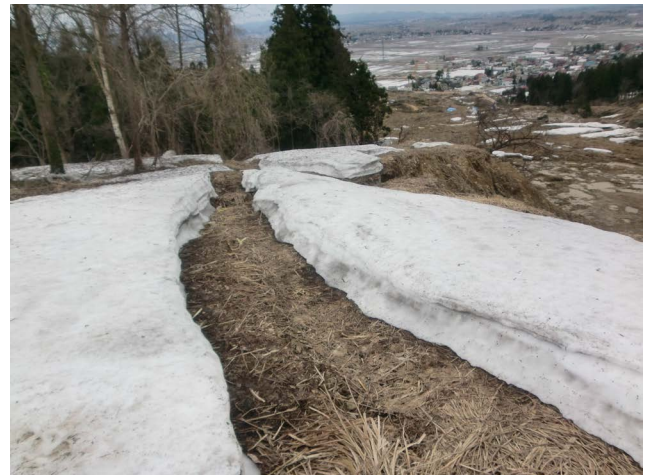
写真6 南西側方崖上部に発生している雁行亀裂。
