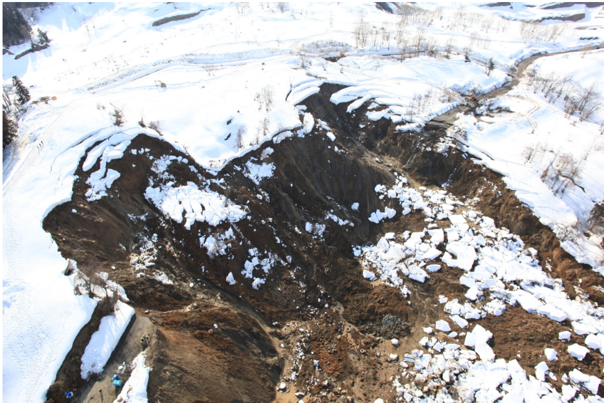
写真 1 滑落崖の両サイドで崩壊が拡大する。背後斜面から多量の地表水及び湧水が流入する。
