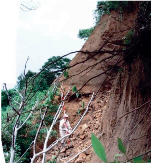
写真－2 Aブロック滑落崖の状況
