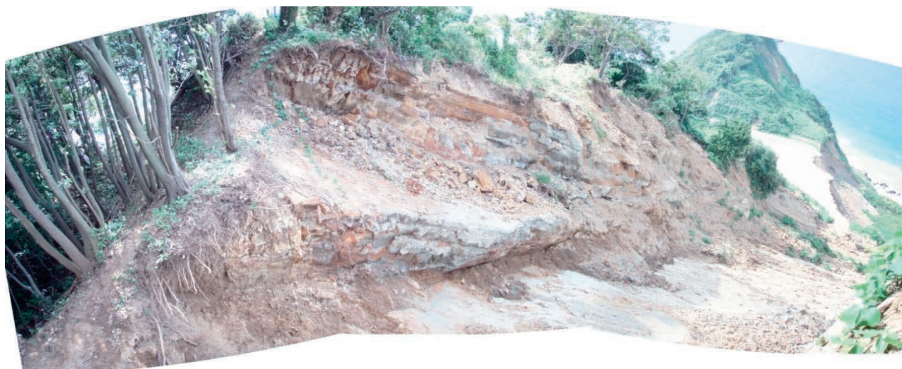
写真-13 稜線争奪の状況 Dブロックの頭部がAブロック側斜面に食い込んでいる
