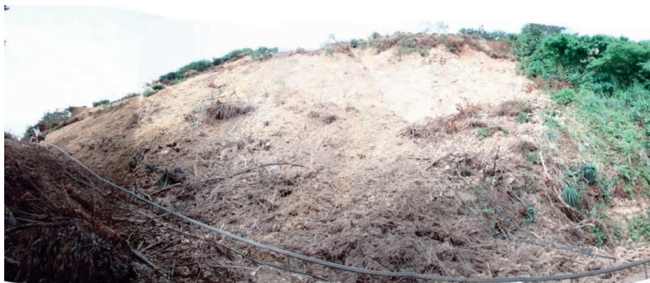
写真－4 Aブロック緩斜面直下に露岩する泥岩不動基盤と判断される
