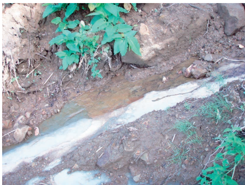
写真-12 Dブロックで確認された地下水湧出
