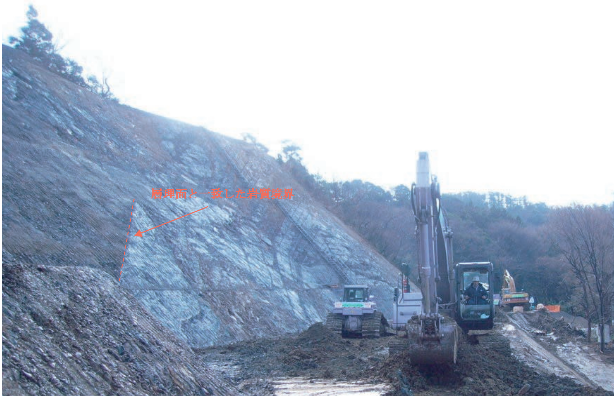
写真-15 排土後斜面の地質状況 (H20. 3 撮影)
