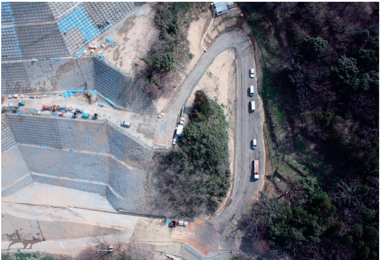
写真-14 追い込んで排土した後の斜面の状況 (H20. 5撮影)
