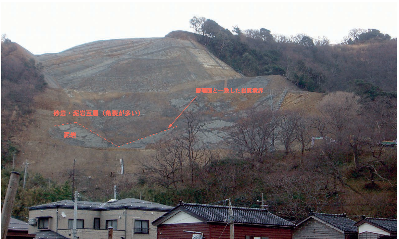
写真-16 排土後斜面の地質状況 (H20. 3 撮影)
