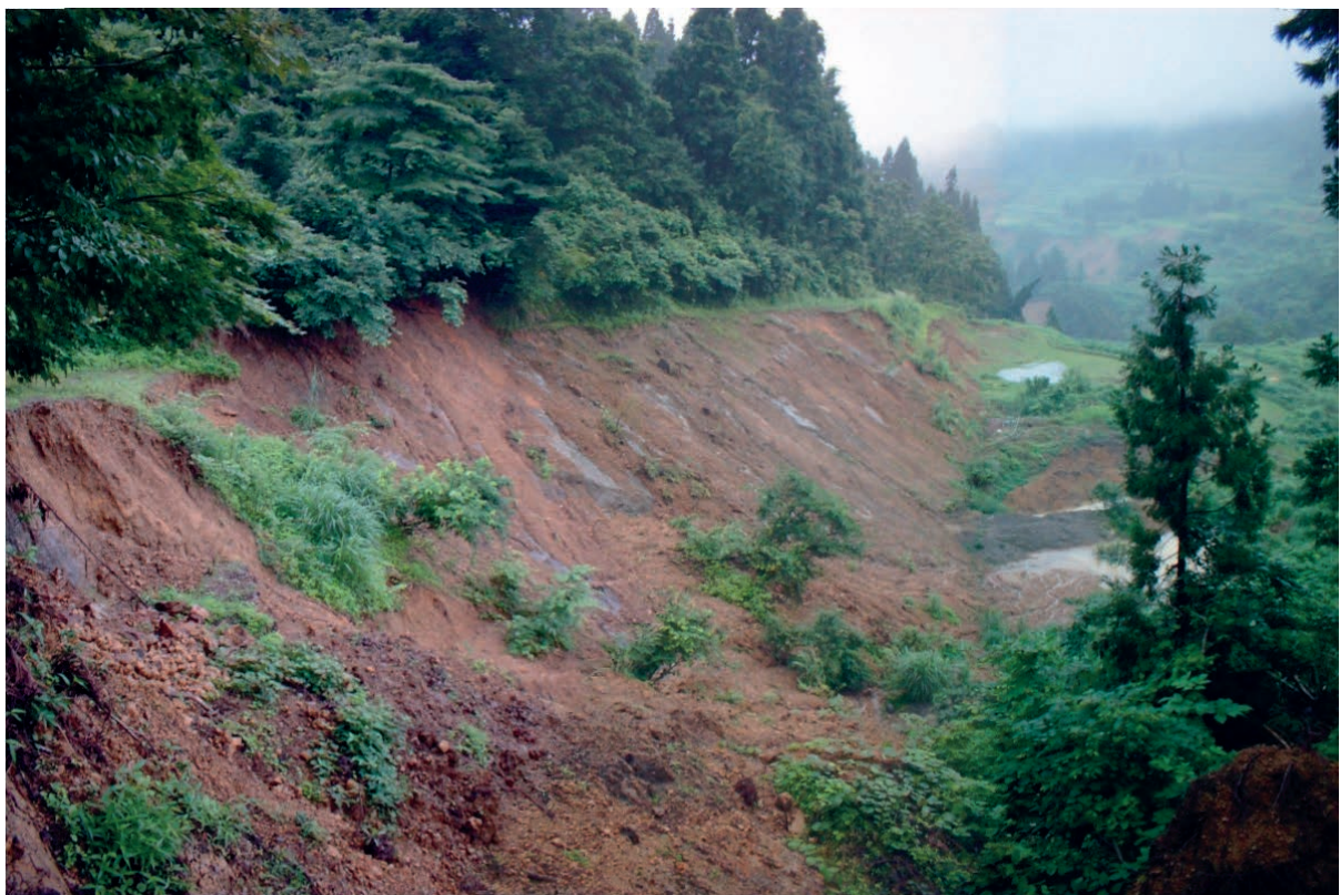
③ A-1 ブロック左側壁をなす泥岩の層理面
