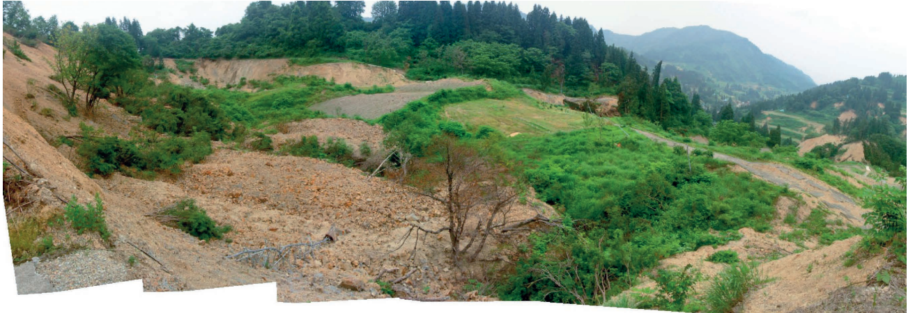
② A-1 ブロック市道および農地の被災状況
