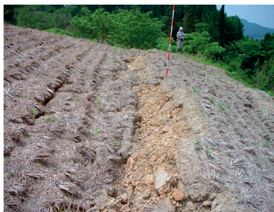
写真 2-3 ③の転倒亀裂群
