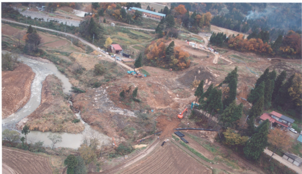
移動土砂が飯田川を閉塞した。左の河川は河川応急迂回路である。C1-3 ブロック冠頂滑落崖は落差10m程度を形成し、中腹部～末端は比較的緩斜面となる。県道の破損残骸が河川脇に確認できる。 <撮影:平成14年11月中旬>
