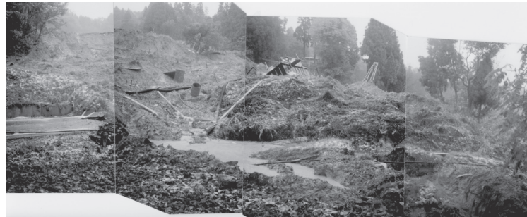
写 3-8, C1-3 ブロックを県道より望む。C1-3 滑落崖は 10m 程度を呈する。工事の資材が 30~50m 程度移動する。(撮影: 11月9日)
