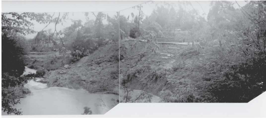
写 3-9, 飯田川に堆積した土砂。斜面中段からの土砂の押し出しが確認され、随時表層部で崩壊している。(撮影: 11月9日)
