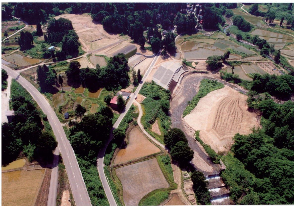
工事施工後写真2 <撮影:平成16年6月>
