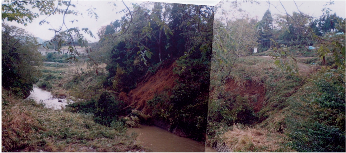
一級河川飯田川に崩落する土砂 <撮影:平成14年11月8日>
