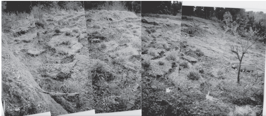
写3-12, C1-1ブロック頭部。背後へ波及を繰り返し拡大した様子が窺える。 (撮影：11月14日)
