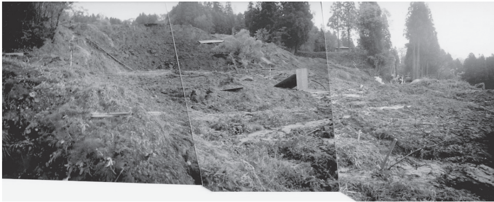
写 3-14, 県道より C1-3 ブロック頭部を望む。C1-3 滑落崖が 10m 程度の急崖を呈し、滑落崖より県道付近まで平坦面を形成した。滑落崖直下は沈降部となり、小規模な池が存在した。（撮影：11 月 12
