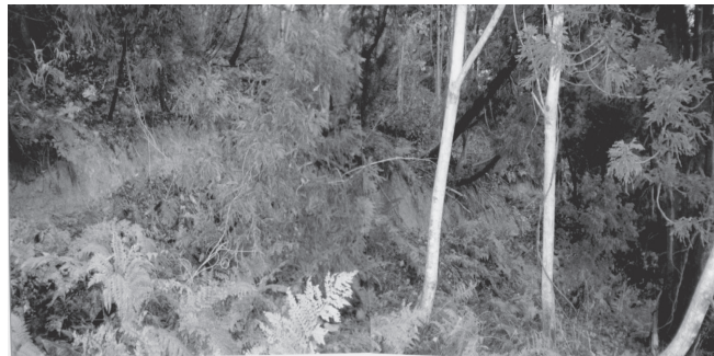
写 3-10, C1ブロック頭部滑落崖1~2m明瞭な輪郭を示す。(撮影: 11月26日)
