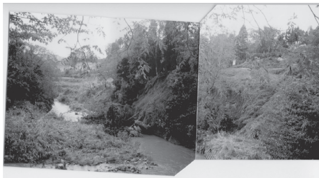
写 3-5, 一級河川飯田川に崩落する土砂 (撮影：11月8日)
