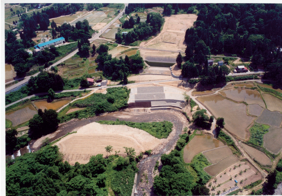
工事施工後写真1 <撮影:平成16年6月>
