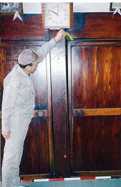
木地屋集落民家の変状状況（H10年 5 月） 基礎部が地すべりに引張られ、家屋全体は上流側へ 傾斜 右写真は室内の被害状況
