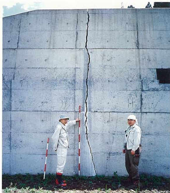
第 5 号砂防ダム本堤の破断状況（H10年 5 月） H 8 年12月竣工、H 9 年融雪期本堤左岸側に縦亀裂が発生 H10年 5 月に 2 ～ 3 cm まで拡大し破断に至った
