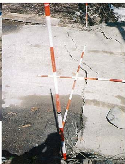
第 5 号砂防ダム本堤の破断状況（H10年 5 月） H 8 年12月竣工、H 9 年融雪期本堤左岸側に縦亀裂が発生 H10年 5 月に 2 ～ 3 cm まで拡大し破断に至った
