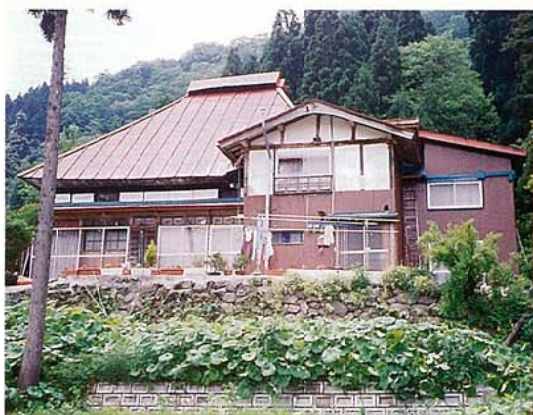
木地屋集落民家の変状状況（H10年 5 月） 基礎部が地すべりに引張られ、家屋全体は上流側へ 傾斜 右写真は室内の被害状況
