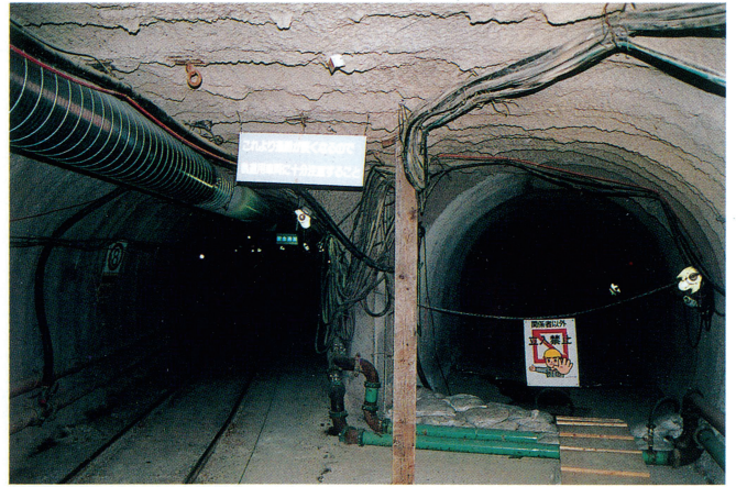
写真④ 2号・3号排水トンネル分岐部
