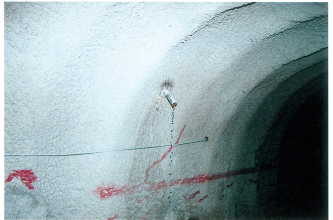
写真⑥ 2号排水トンネル水抜きボーリング状況
