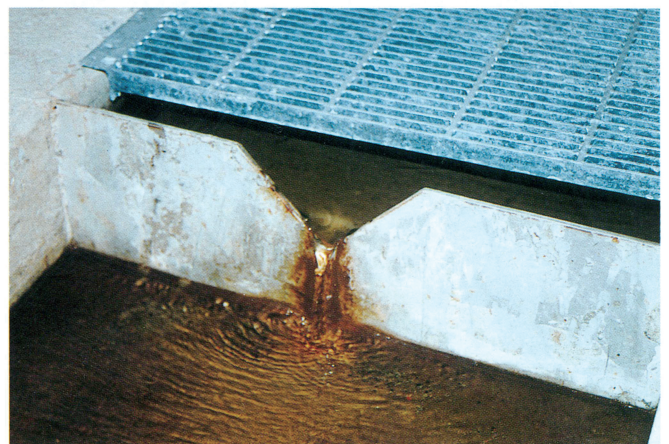
写真⑦ 2号排水トンネル下流端での排水状況
