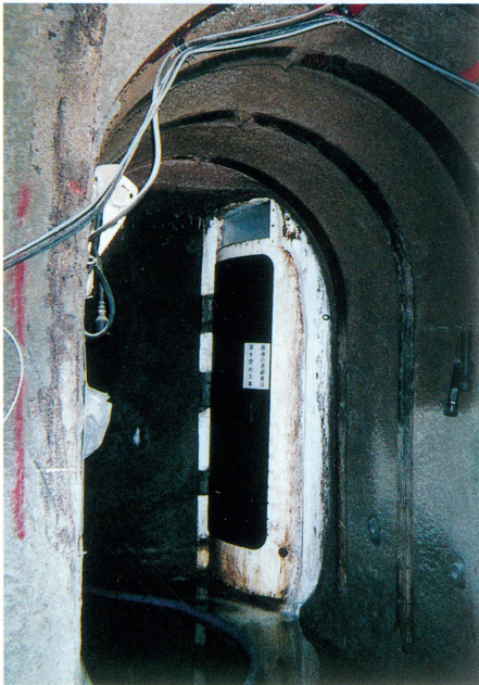
写真② 3号排水トンネル・ 1号立坑アクセス部
