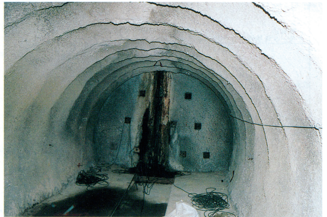
写真⑤ 2号排水トンネル終点部
