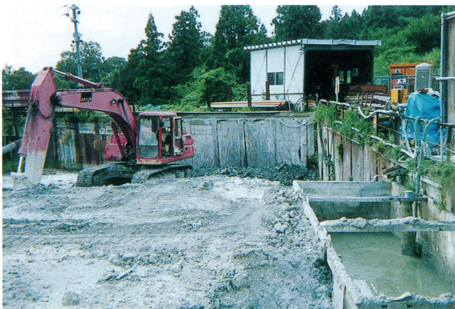
写真③ 3号排水トンネル仮設工(ズリ捨て)
