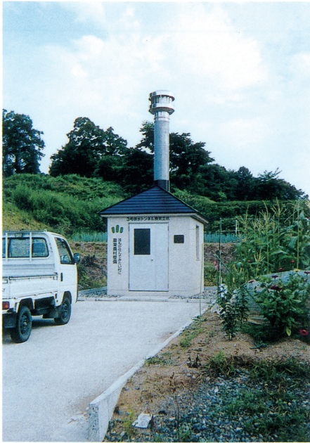
写真① 3号排水トンネル 1号立坑上屋
