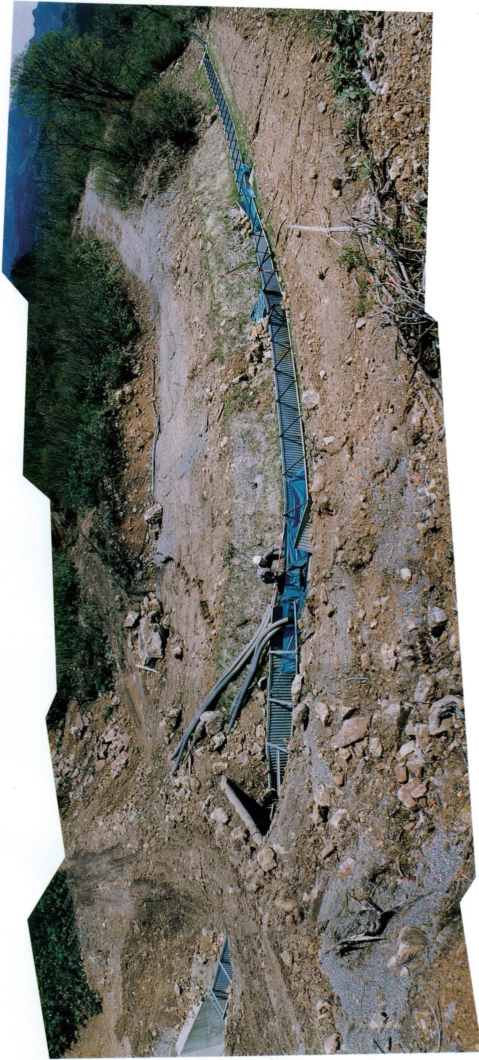
写真-4 頭部の亀裂により赤松沢沿いの水路が被害を受けた状況。奥は写真-3の滑落崖へ連続する。亀裂より左手は不動地(平成3年4月撮影)。
