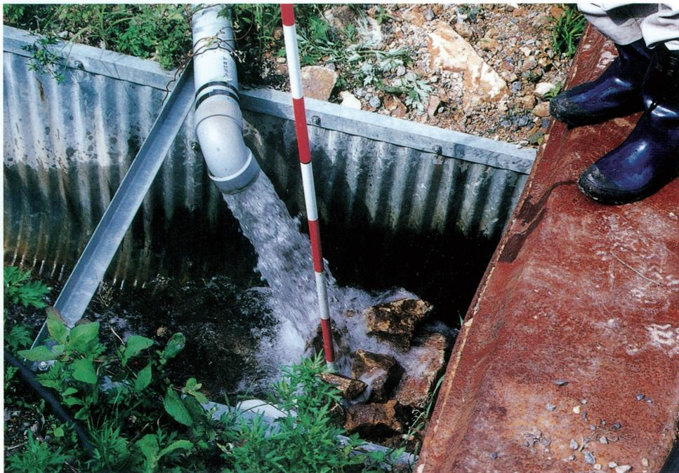
写真-9 No.6号集水井からの排水口の1つ。約300ℓ/min（平成9年5月）。
