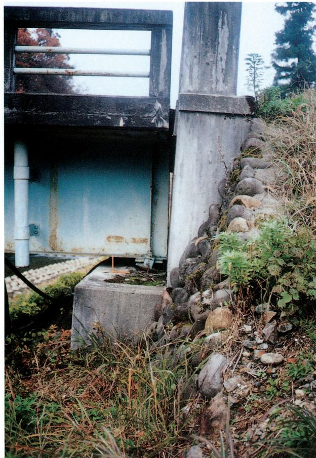
**写真3** 山橋では、橋の延長方向に圧縮されるような変状が徐々に進行していた。この写真では、橋桁が橋台に押しつけられ、シューが回転し浮き上がっている。
