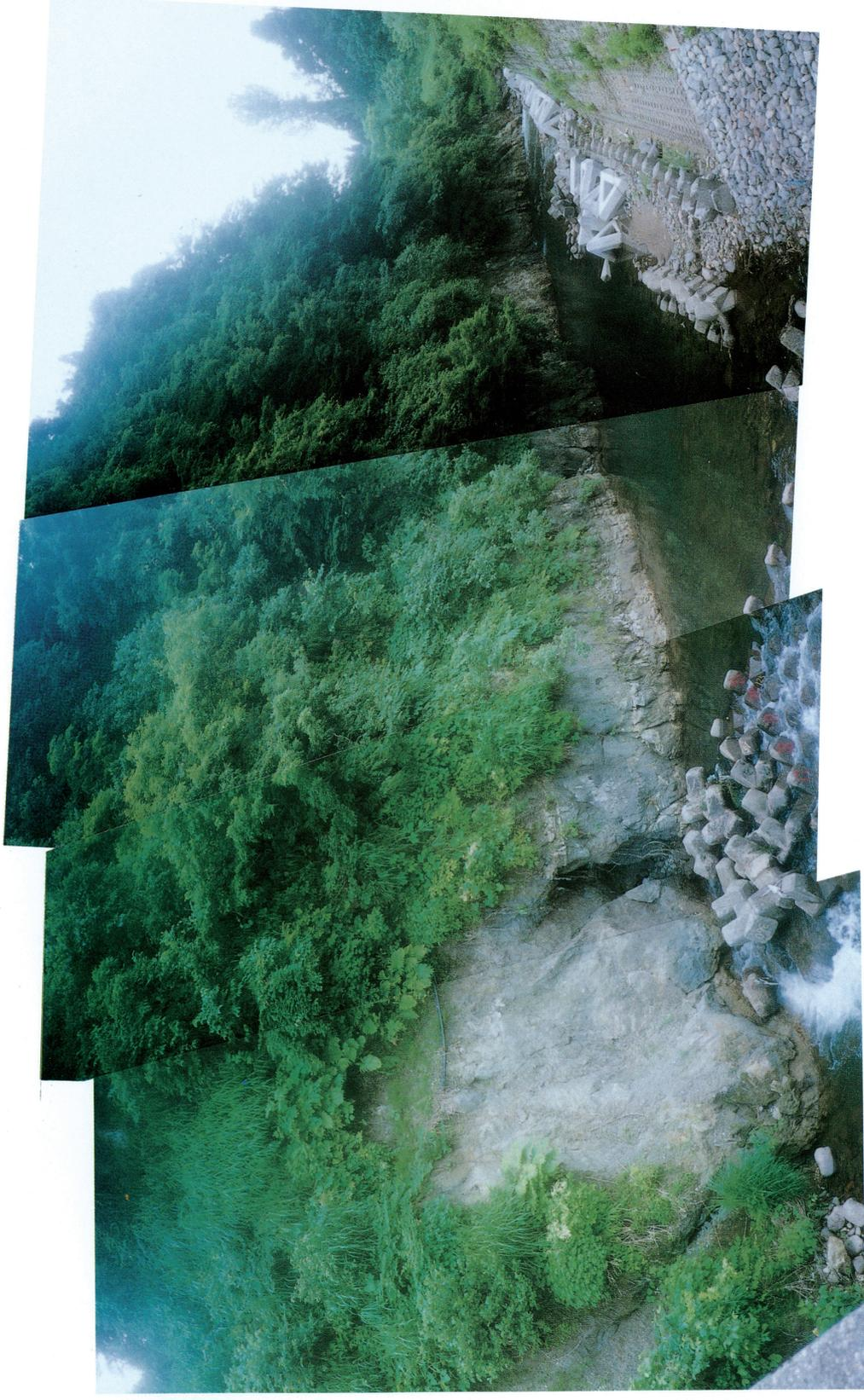
**写真5** 山橋の上流側にそびえる、ガラス質凝灰岩より成る小岩体の、西川に面した側では、時々表層剝離や小崩壊が発生している。なお、川の中の異形ブロックは、洪水後、それ以上の河川侵食を防止するために設置されたものである。
