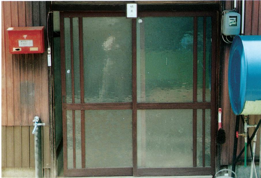
**写真2** 西名集落内では、以前から家屋の傾動やその基礎の亀裂等の変状が徐々に進行している。この家では、全体が右側（北側）に傾動し、玄関の戸との間に隙間が出来、それをくさび型の板で補修してある。10数年前から変状があるとのことである。
