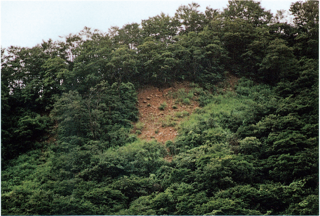
写真一 3 地区西側の滑落崖上部に露出するの魚沼層主に巨礫を混在する砂・シルト岩から成る
