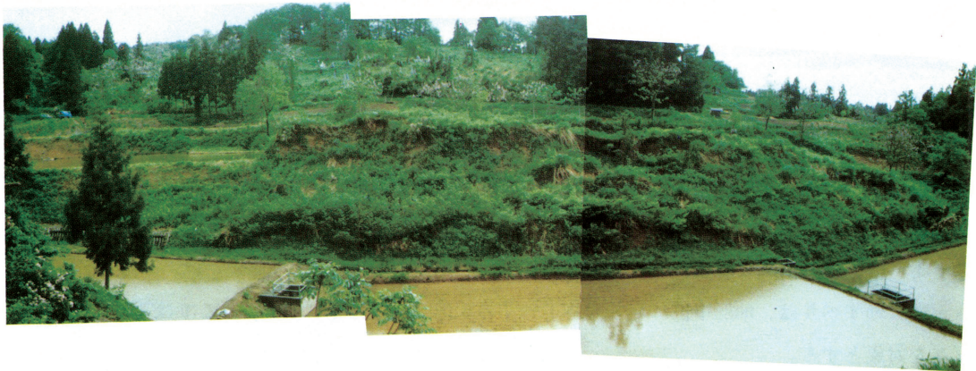
Ⅱ 地区，Aブロック全景……脚部は隆起地塊，中腹は墓地として利用されるが，尾根の大開口亀裂から脚部まで長さ 250 m の大規模な風化岩すべり。 末端の沢は昭和54年に埋設暗渠水路として整備済。
