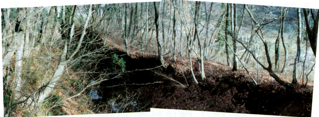
① 地区Aブロック頭部の開口亀裂
