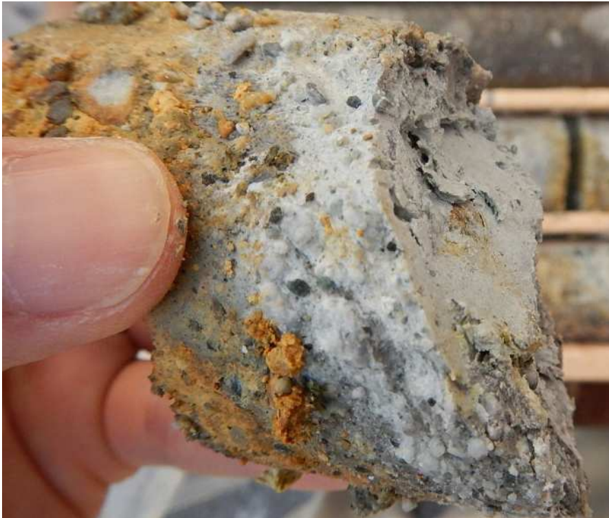
粘土主体部分
