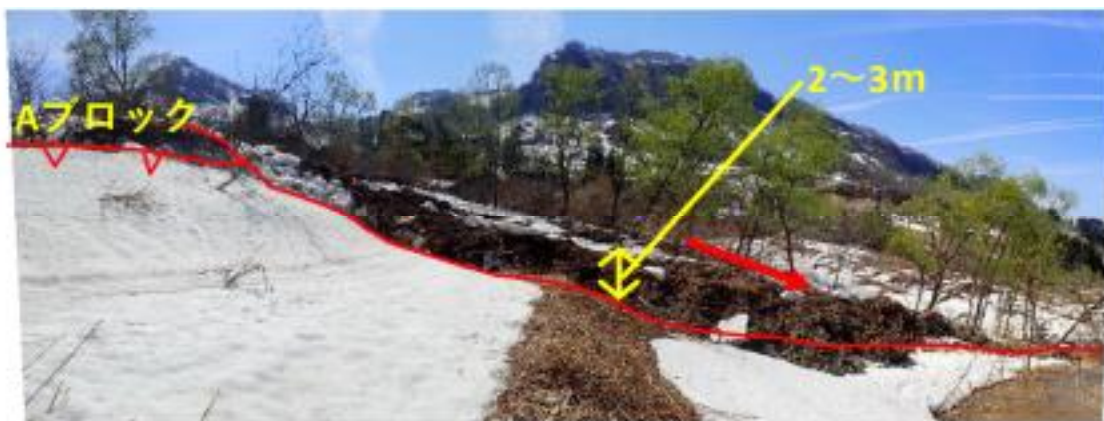
写真2. 7 Bブロック東側方部状況 上部ブロック末端部を切って斜面上部へ連続する 側方リッジ：比高2～3m
