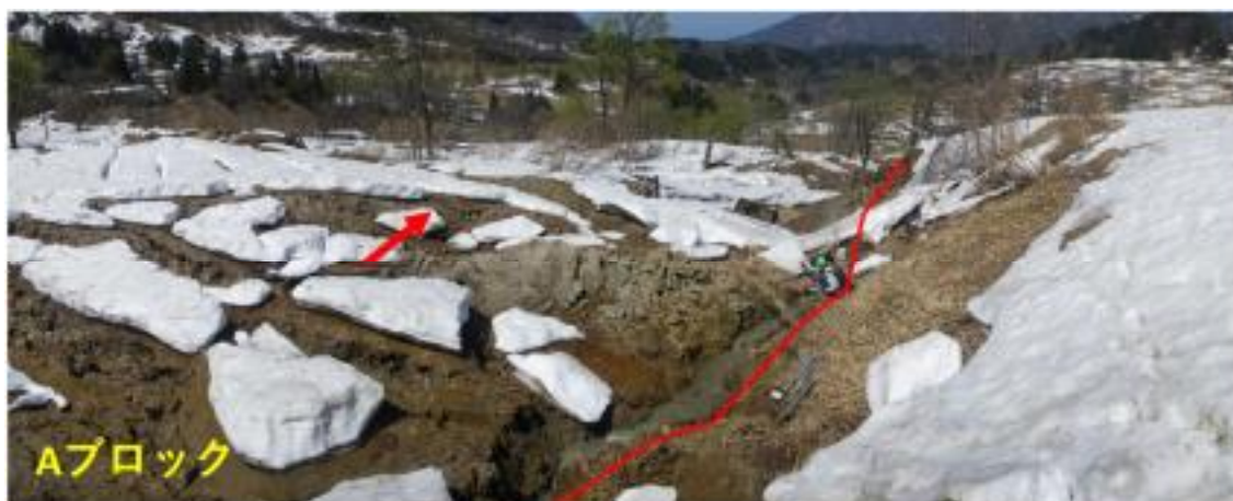
写真 2. 2 A ブロック東側方部状況
