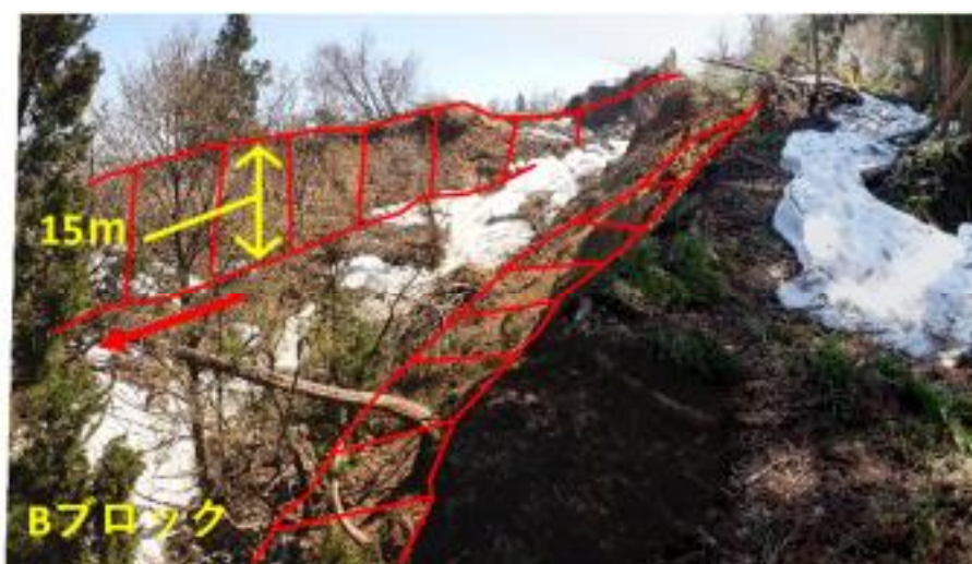
写真2. 9 Bブロック西側方部状況 尾根を分断する線状凹地が認められる 側方崖：比高最大15m
