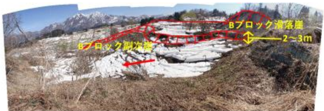
写真 2. 6 B ブロック副次崖状況 副次崖：比高 2~3m
