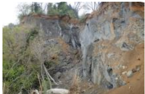
写真 5. 1 滑落崖の状況
